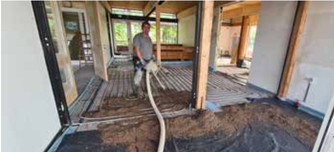
Die alten Heizkörper sind raus, dafür eine neue Fußbodenheizung
